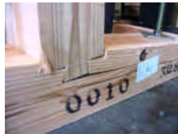
写真 4.3.4 下部材の割れ（最大変形時）
