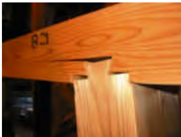
写真 4.6.5 上部材の割れ（最大変形時）
