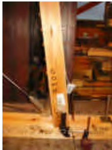
写真 4.6.3 右下接合部（最大変形時）
