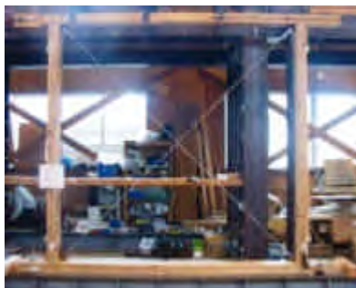
写真 4.4.1 実験供試体（初期状態）
